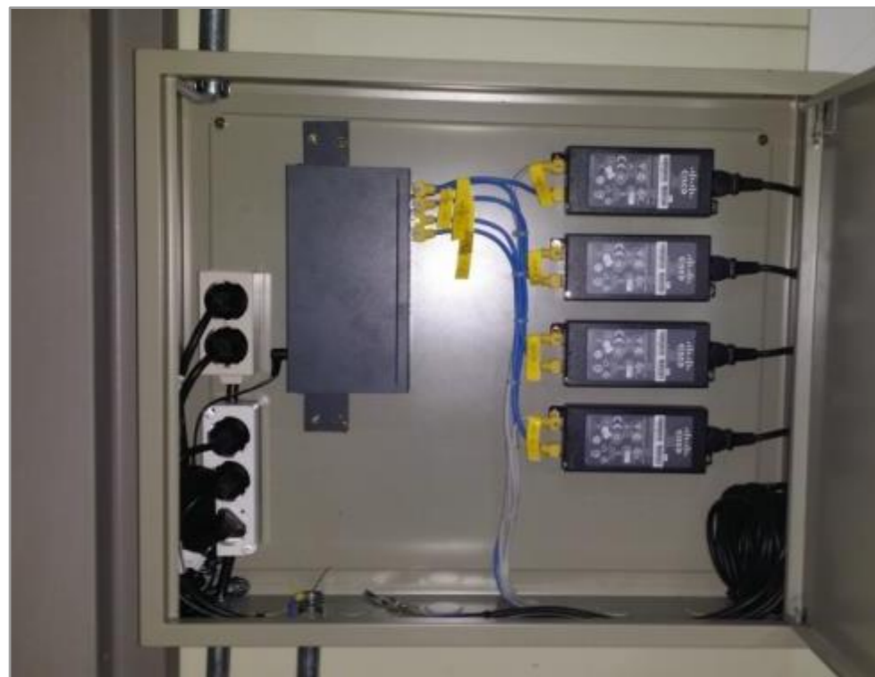
무선 AP 전원 공급 장치 설치
