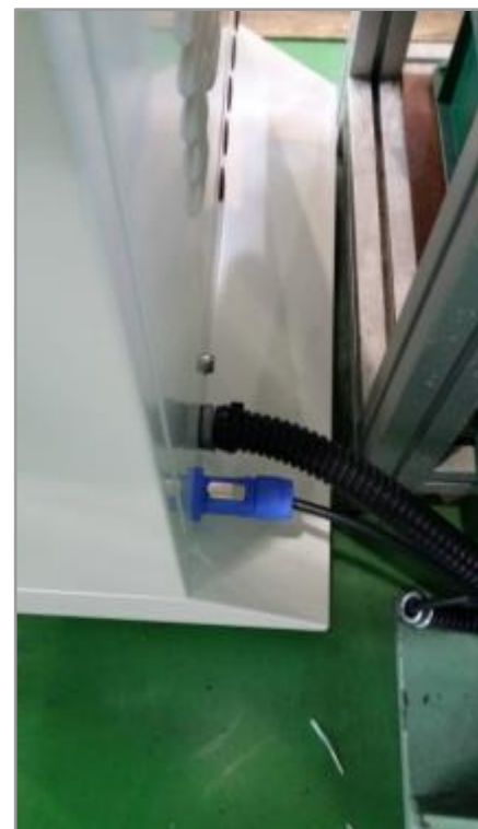
단말기 Cable 배관
